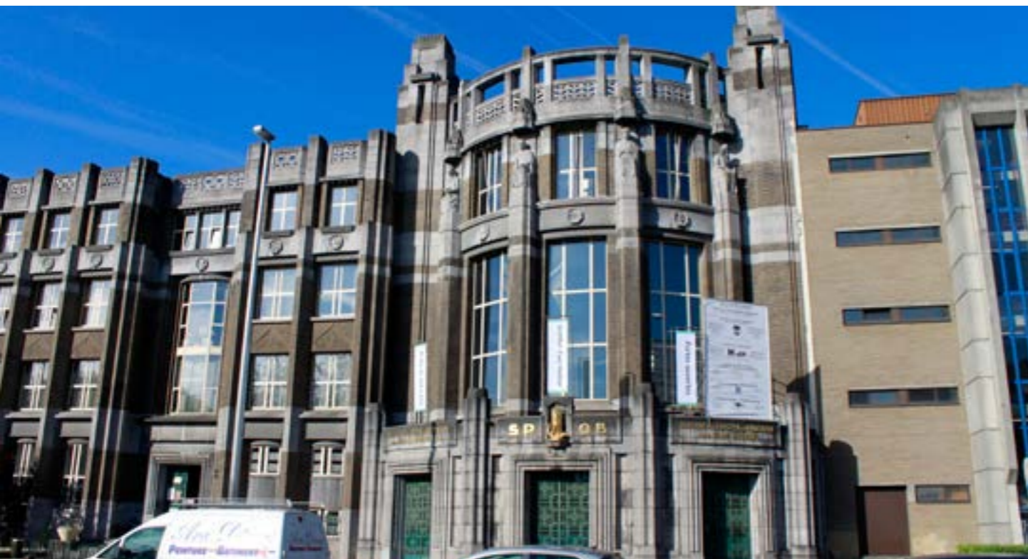
Monumentale art-decogevul van het Instituut voor Kunsten en Ambachten aan de Slachthuislaan. Naast enkele gedenkplaten die in het instituut werden aangebracht, werd er in de inkomhal ook een beeld opgericht voor alle slachtoffers van de twee wereldoorlogen.
