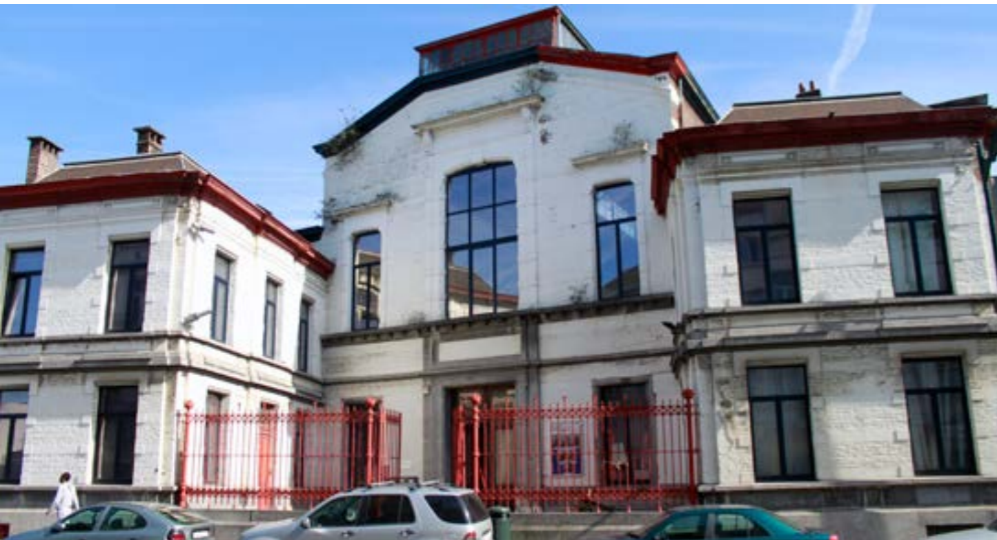
De Curo-Hall in de Ropsy-Chaudronstraat herbergt vandaag het Huis voor de Sociale Cohesie maar omwille van het scholentekort in Kuregem zal dit voormalig schoolgebouw over enkele jaren opnieuw een school worden. Het Huis voor de Sociale Cohesie verhuist dan naar een nieuw gebouw in de Scheikundigestraat.
