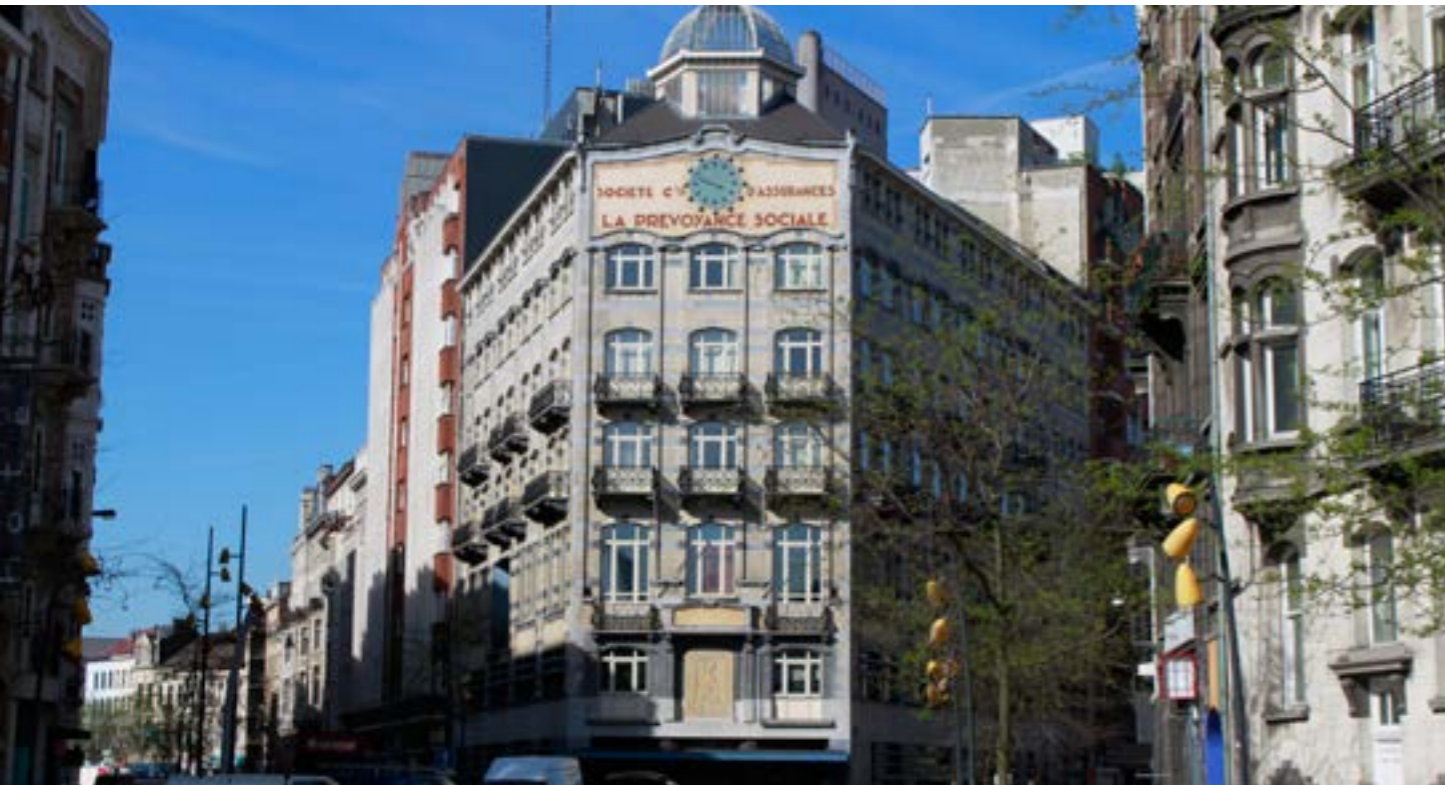
De coöperatieve verzekeringsmaatschappij de Sociale Voorzorg werd opgericht op 25 september 1907 onder de vleugels van de Belgische Werkliedenpartij. In 1911 krijgt Richard Pringiers de opdracht om voor de socialistische verzekeringscoöperatieve een nieuw gebouw uit te tekenen. De gevels van het late art-nouveaugedebouw werden opgetrokken in lichte Silezische baksteen en in blauwe steen en vermelden de verschillende soorten dienstverlening. De plannen voor de verbouwingen van het hoekgebouw in 1931 werden getekend door Fernand en Maxime Brunfaut.
